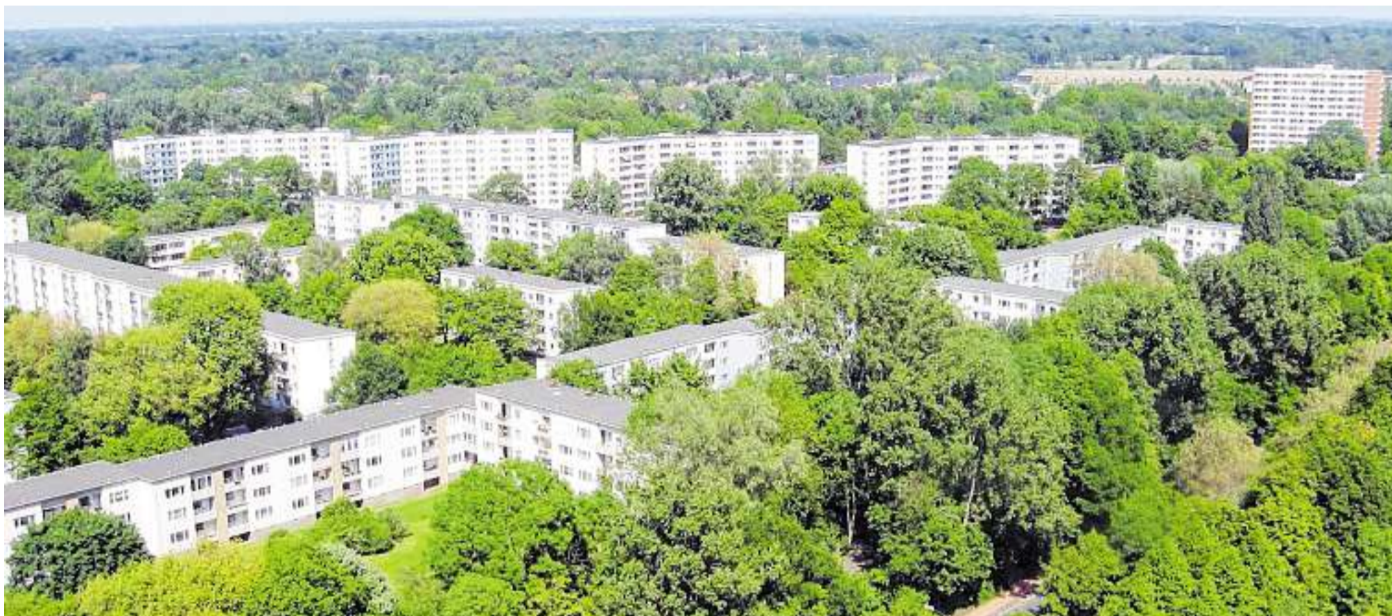
Die Neue Vahr entstand in einer riesigen Wüste aus Schlamm. 60 Jahre nach Baubeginn sind die Häuser von Bäumen umsäumt.
